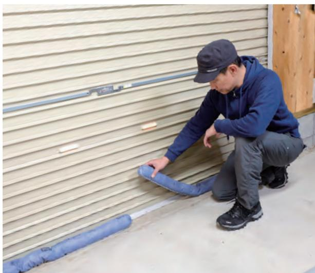
シャッター下の隙間からの水の浸入を防止
